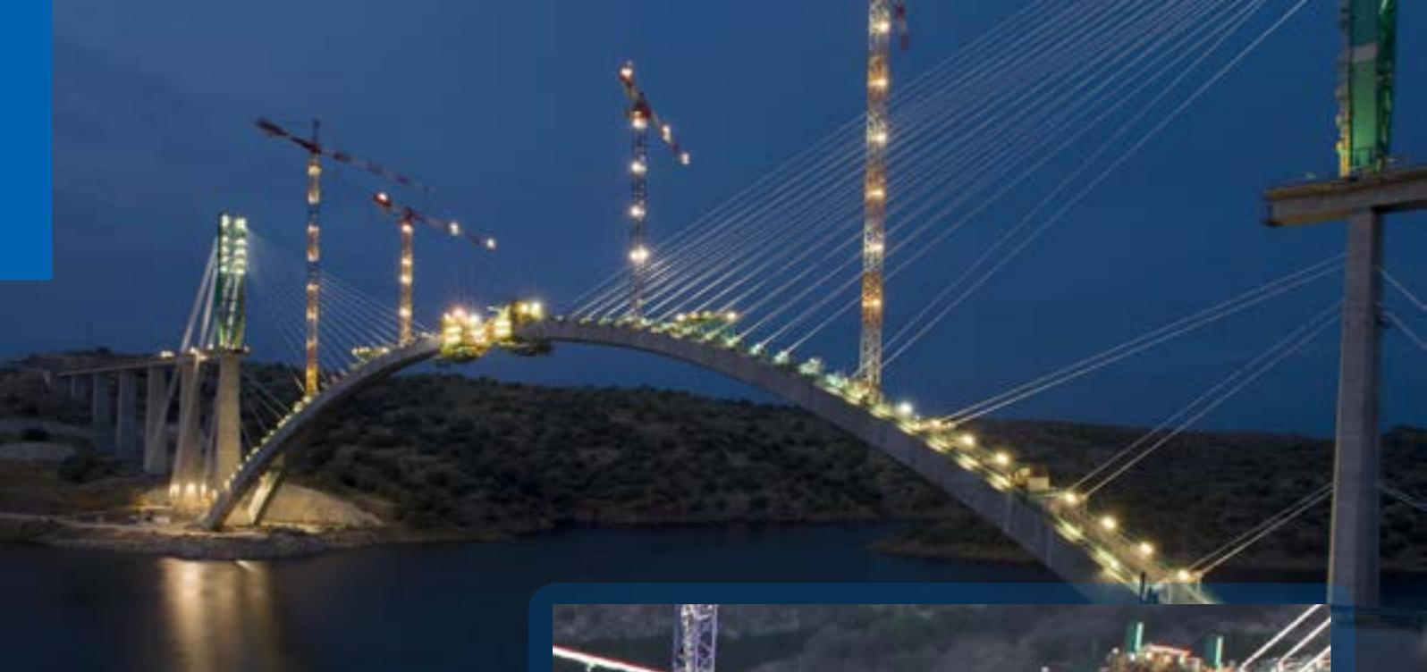
Si se compara sólo con puentes arco de hormigón, fuera del uso ferroviario, se convertirá en el tercero de mayor luz a nivel mundial, sólo superado por el puente Wanxian en China, con 420 metros, y “muy cerca” del mayor de los puentes entre las islas de Sveti Marko y Krk en Croacia, con 390 metros.
