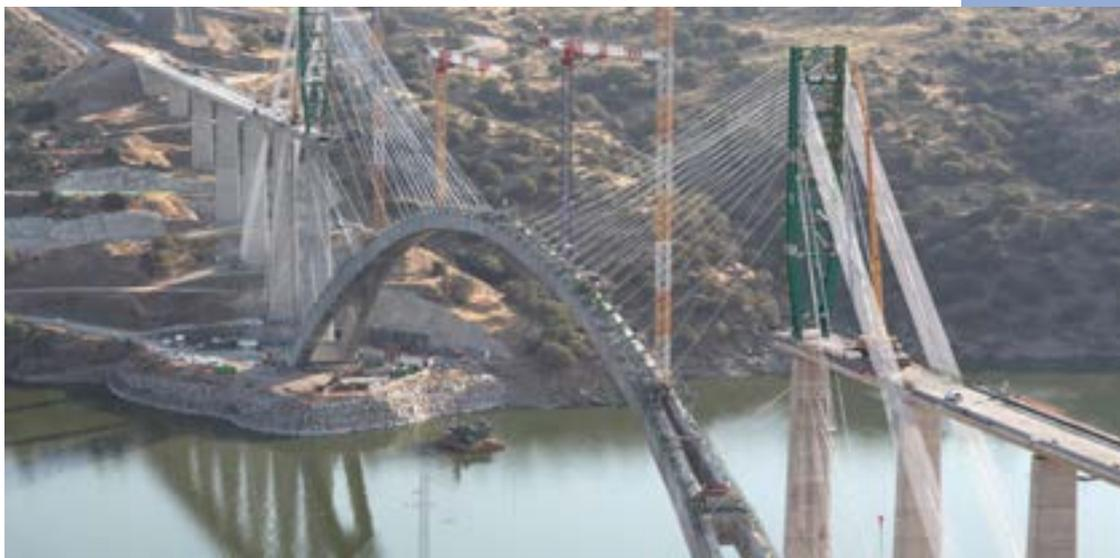
El viaducto se divide en tres partes diferenciadas: dos tramos de acceso y una parte central. En la parte central, presenta un arco de hormigón de 384 metros. Tiene una longitud total de 996 metros, con un tablero resuelto mediante una sección cajón hiperestática de 14 metros de anchura y 3,10 metros de canto y está compuesto por 23 vanos.
